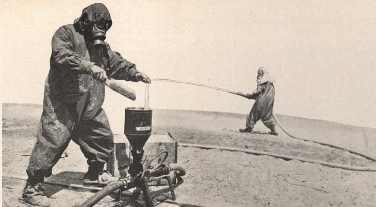
Odkazanie mechaniczne — Aparat „Mira” w zastosowaniu do odkazywania terenu przy pomocy wapna chlorowanego
