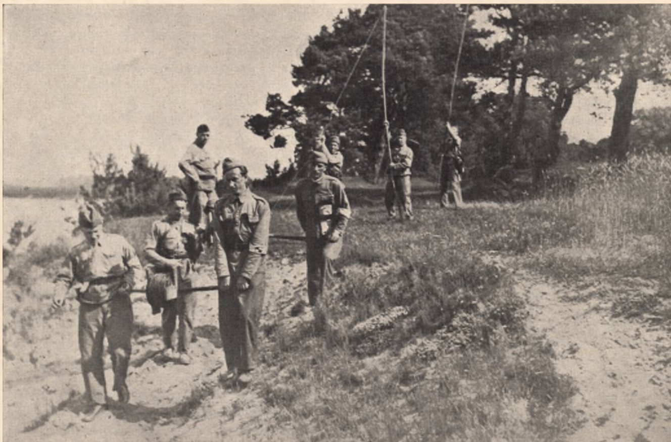
Zakładanie linii telefonicznej przez służbę dozoru
