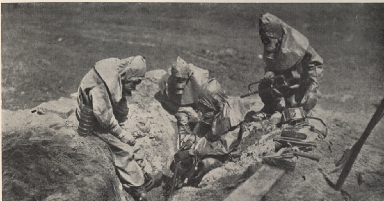
Naprawa przewodu elektrycznego, uszkodzonego wyluchem bomb
