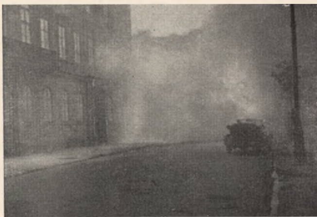
Fala „gazowa” na ulicach Lublina
