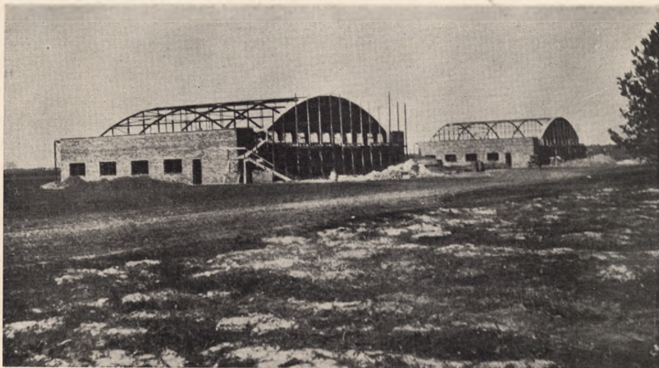
Szkoła Pilotów im. Marszałka Śmigłego-Rydza pod Lublinem w budowie
