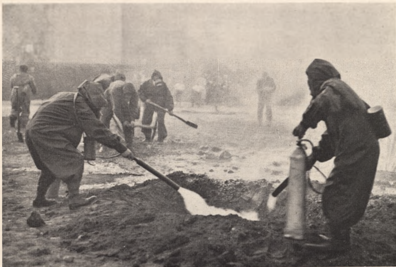
Odkazanie w instalacji gazowej przerwy, spowodowanej wybuchem pocisku
