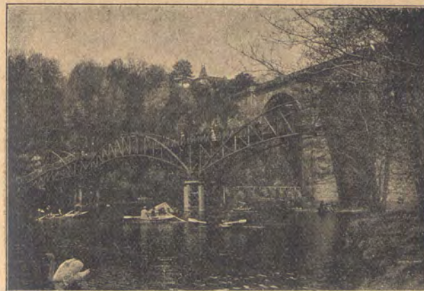
Görlitz: Reisparty mit Viadukt und Laufsteg.
