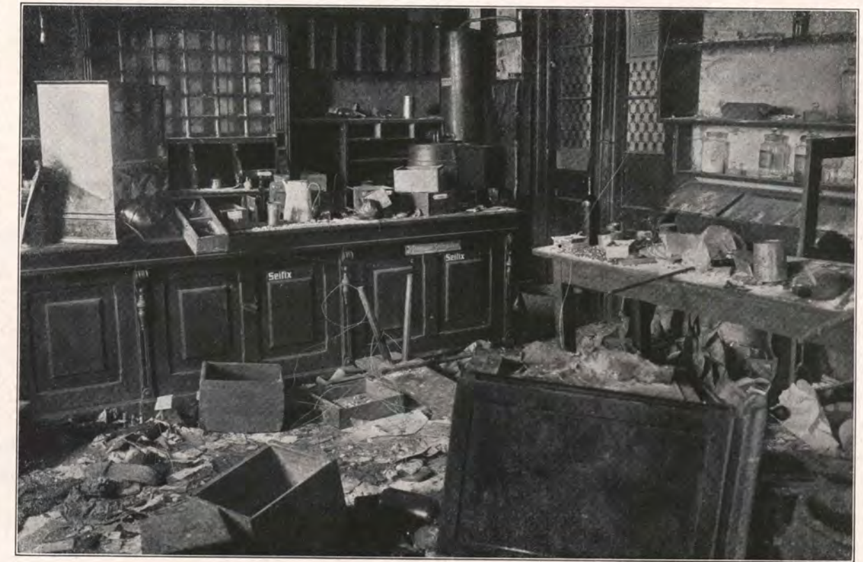
Ein von den Russen zerstörter Kolonialwarenladen.
