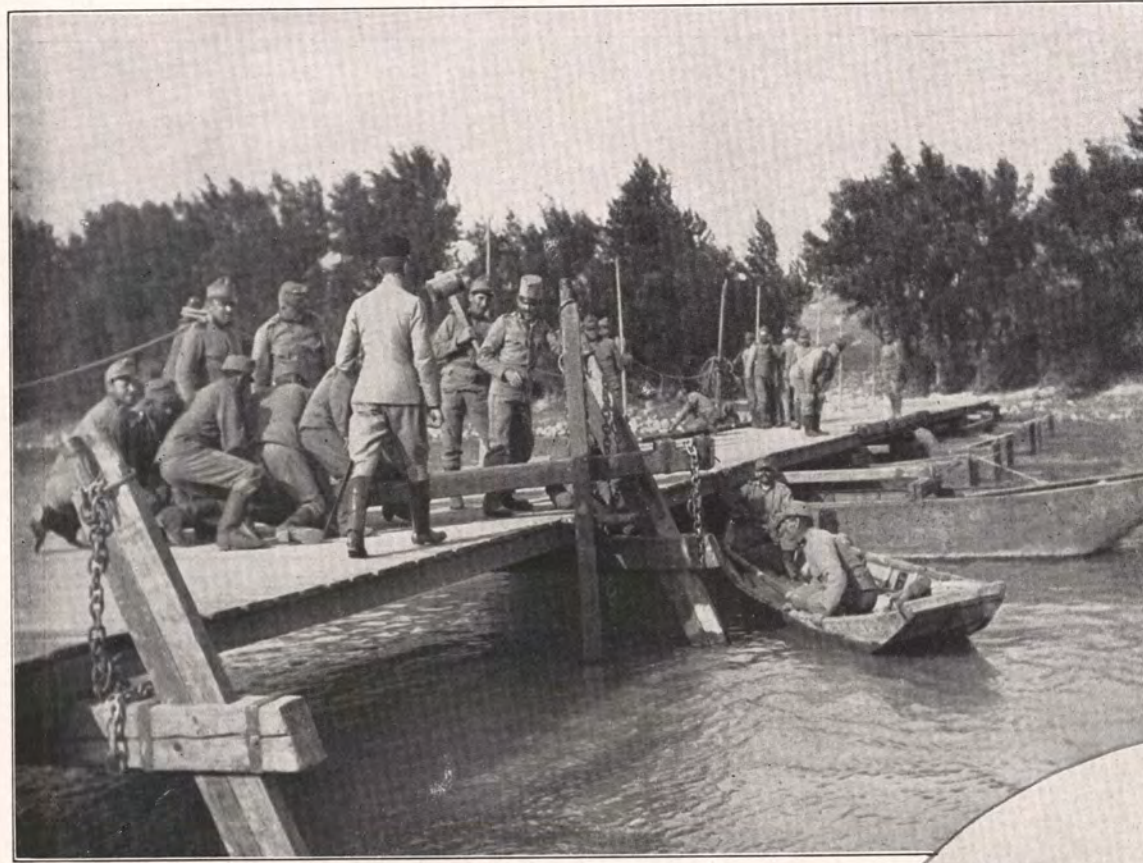
Osterreichisch-ungarische Pioniere beim Brückenbau. (Phot. Perscheid, Wien.)
