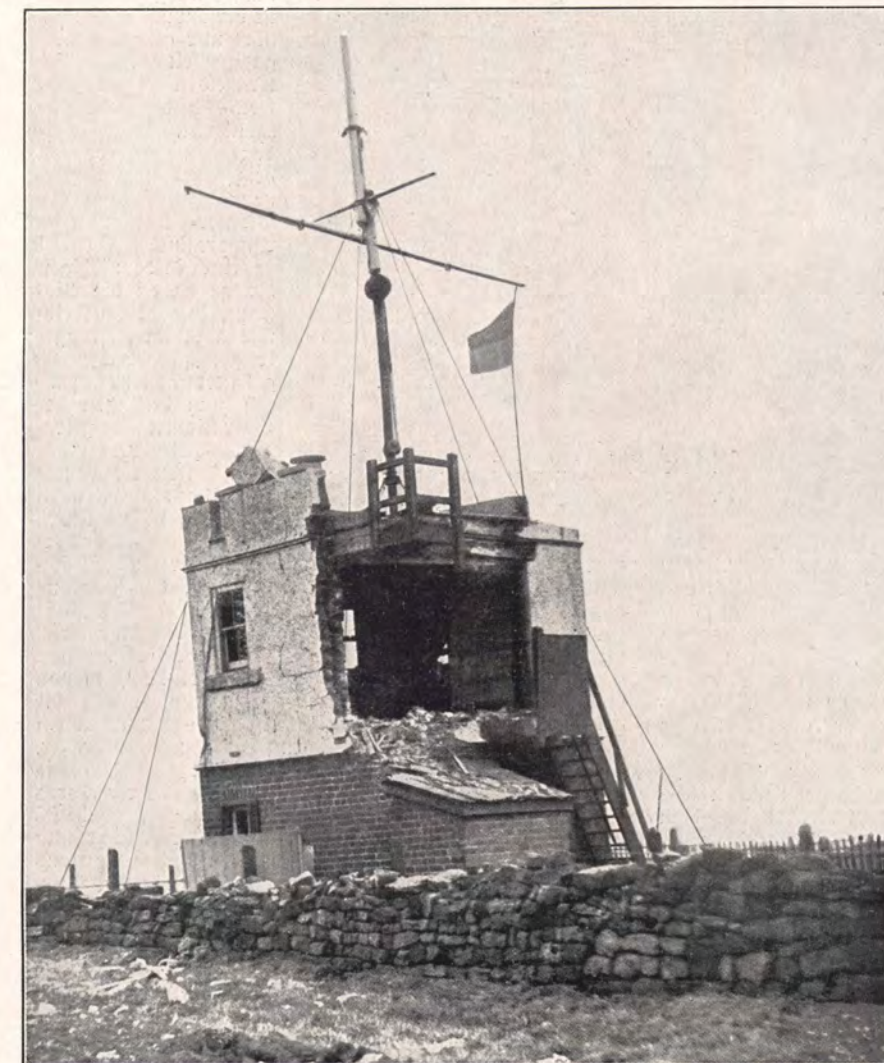
Die zerstörte Signalstation in Whitby.
