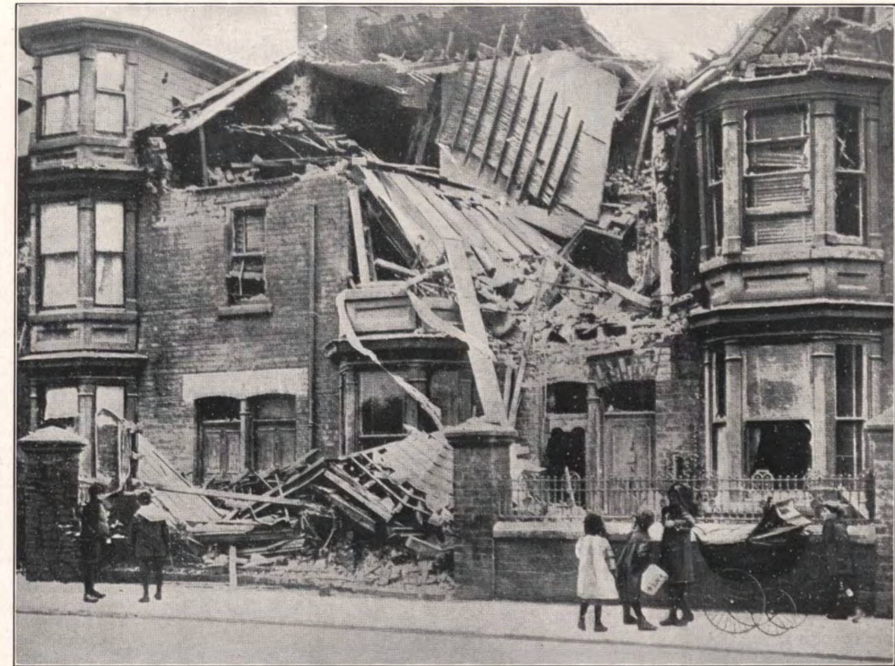
Ein in Trümmer geschossenes Haus in Hartlepool.
