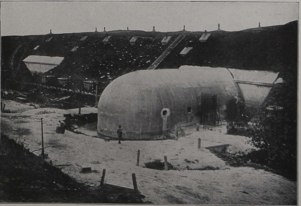
Betonierte Grabenstrieche in der Kehle des Forts 8 der Festung Rowno. (Hofphot. Kühlewindt.)
