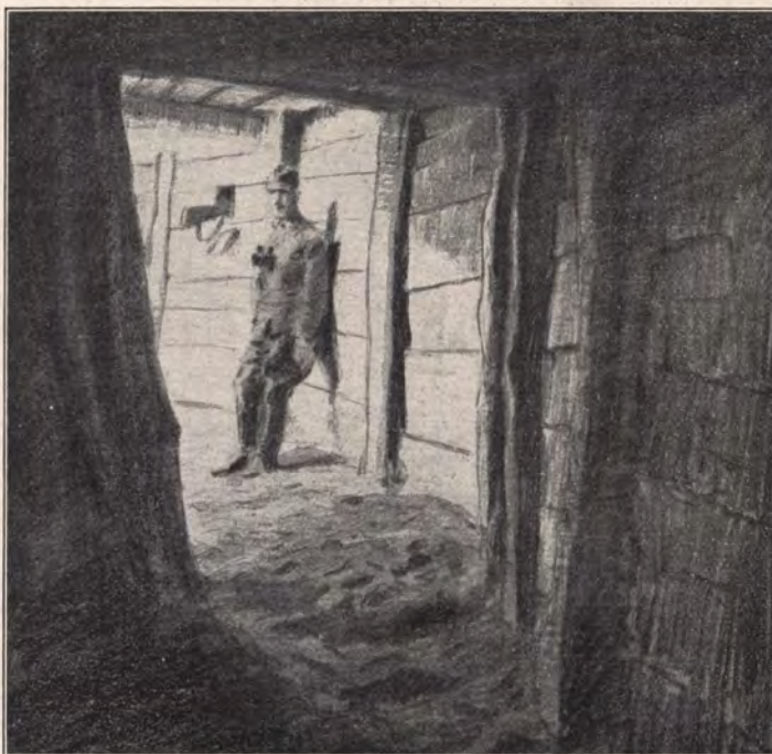
Nördliche Mündung des Verbindungstunnels im Schützengraben bei Urla.
