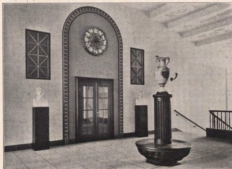
Treppenhaus; II. Obergeschoß.
