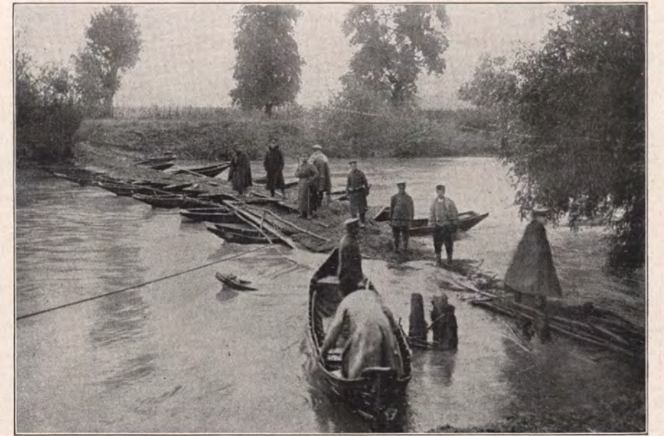
Bulgarische Infanterie beim Bau einer Notbrücke.
