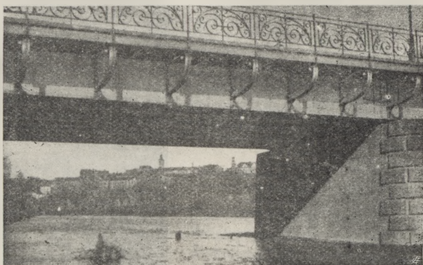
Panorama Cieszyna pod mostu nad Olzą
