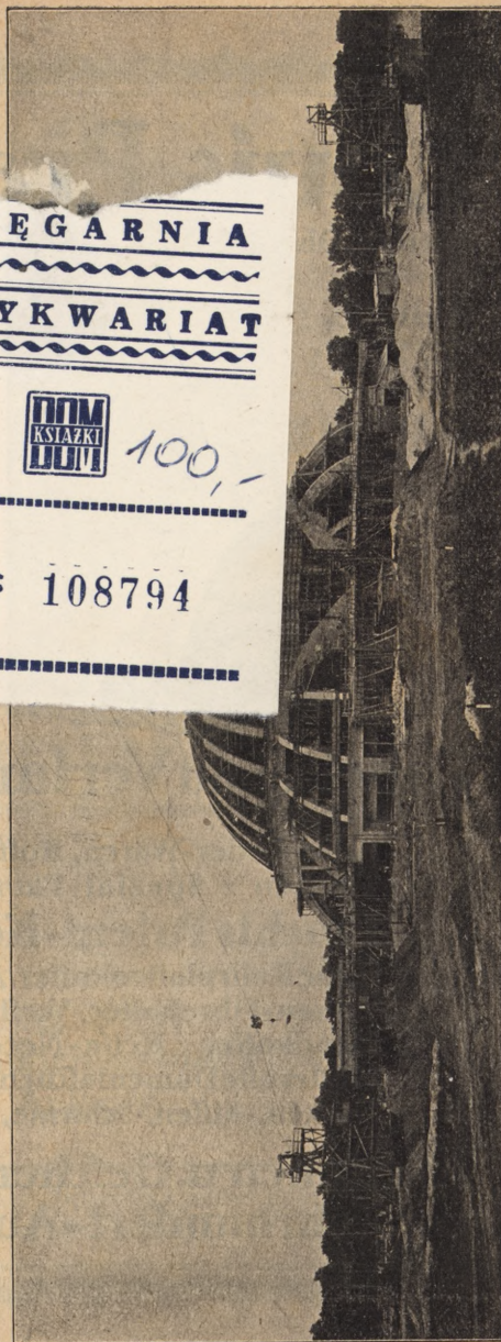
Größter massiver Kuppelbau der Welt. Lichte Spannweite 65 Meter, Höhe 36 Meter
