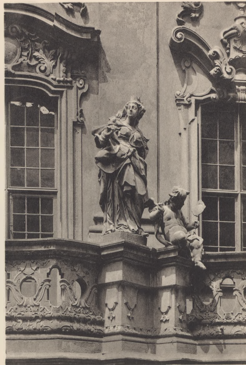
BALKONBRÜSTUNG über dem Hauptportal.
