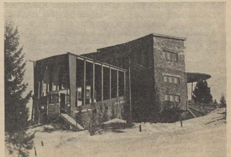
Kolejka górską w Krynicy. Stacja dolna
