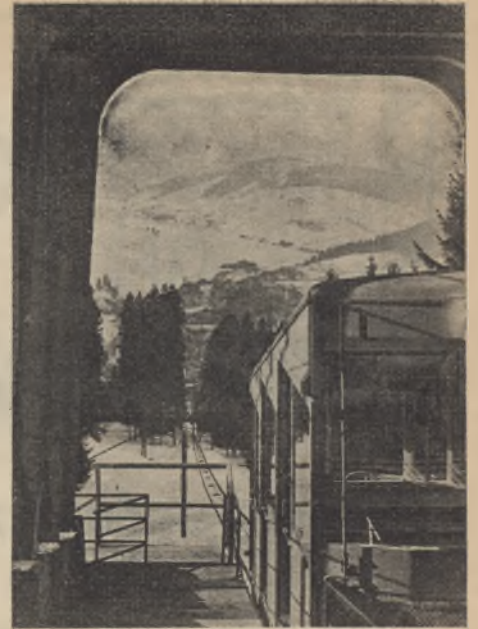
Stacja górna kolejki górskiej w Krynicy
