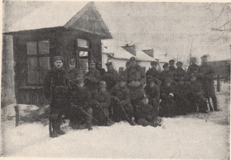
Pluton ppor. Boğuckiego na odcinku pod Cytadela.
