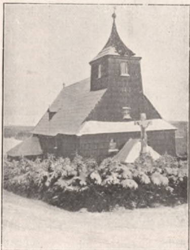
Alte Holzkirche in Grunwald
