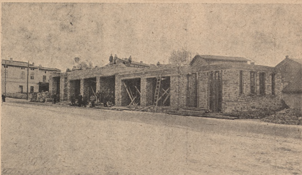
Budowa Domu Legionowego w Jaworznie.
