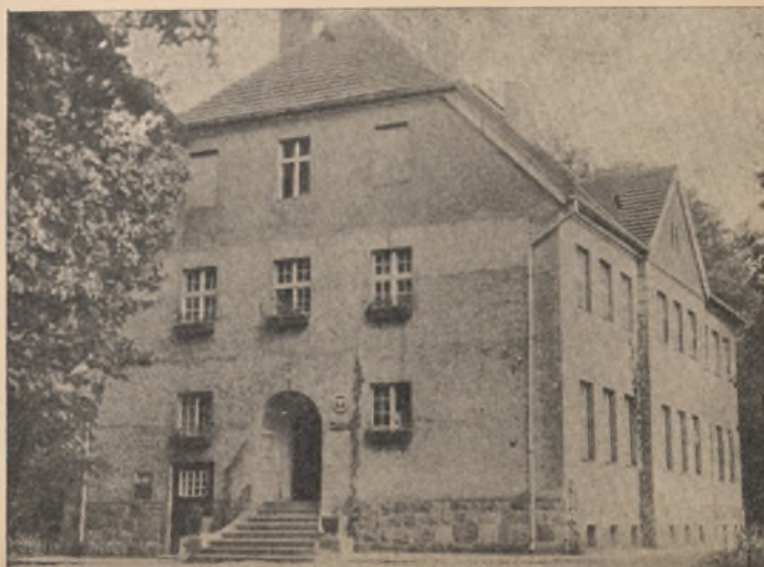
Budynek strażnicy przebudowany spo- sobem gospodarczym.
