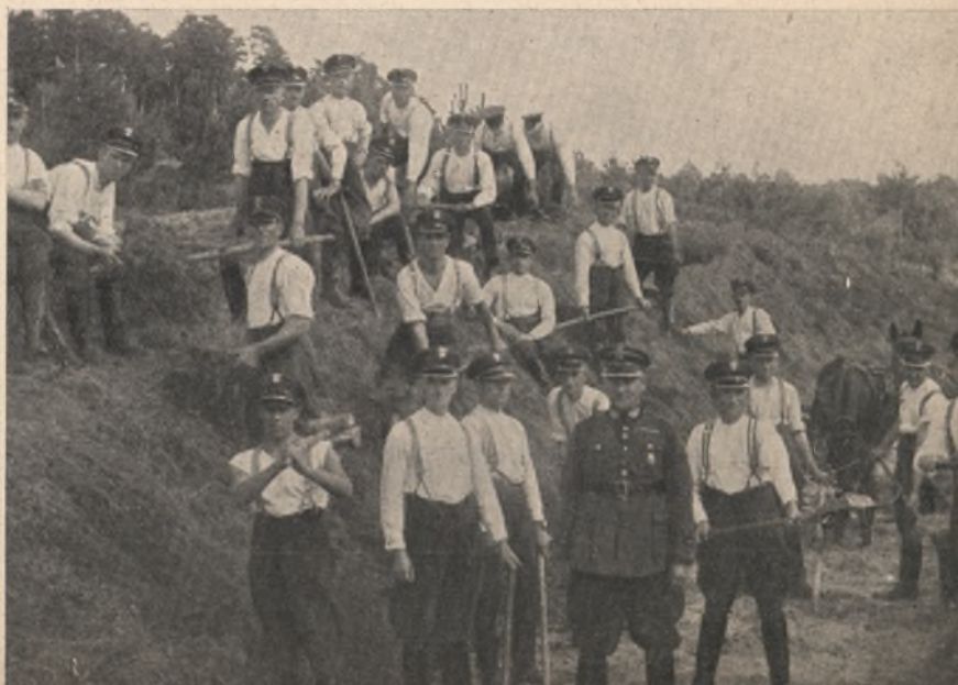
Roboty ziemne przy budowie strzelnicy.
