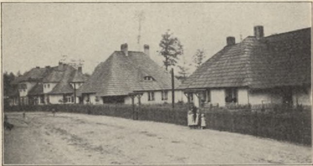
Gieschewald: Bergarbeiterhäuser in der Ringstraße.
