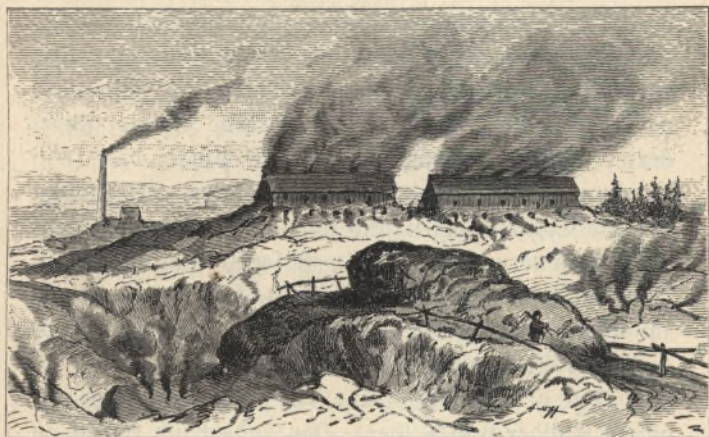
Brandfeld der Fannygrube 1854.
