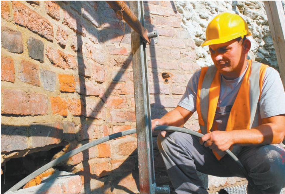
W piątek do wnętrza zabytku wlewano specjalną zaprawę. Czasem zdarzało się, że... wypływała z muru kilka metrów dalej. To dowodzi, że fortyfikacje wymagały dodatkowego wzmocnienia.
